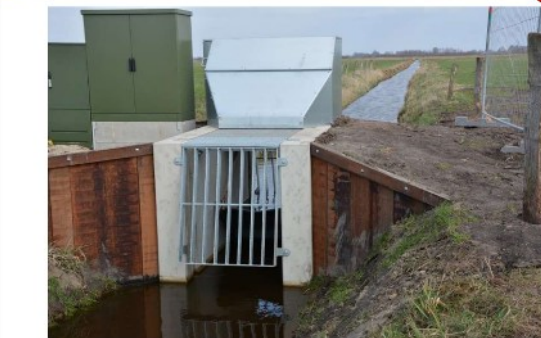
Stauwehr am Großsander Schloot, April 2021, Blick ins Plangebiet
