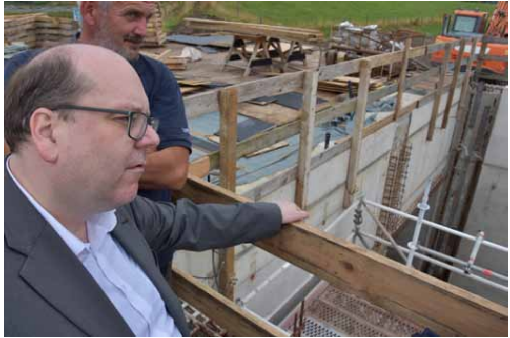
Minister Christian Meyer mit Polier Steffen Martin vom Bauunternehmen Ludwig Freytag am Einlassbauwerk des Polders Coldemüntje.
