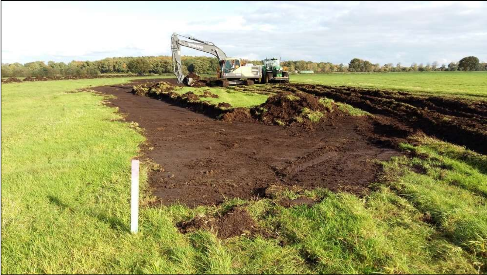
Bau der Mulde auf F1Stk 13, Oktober 2020
