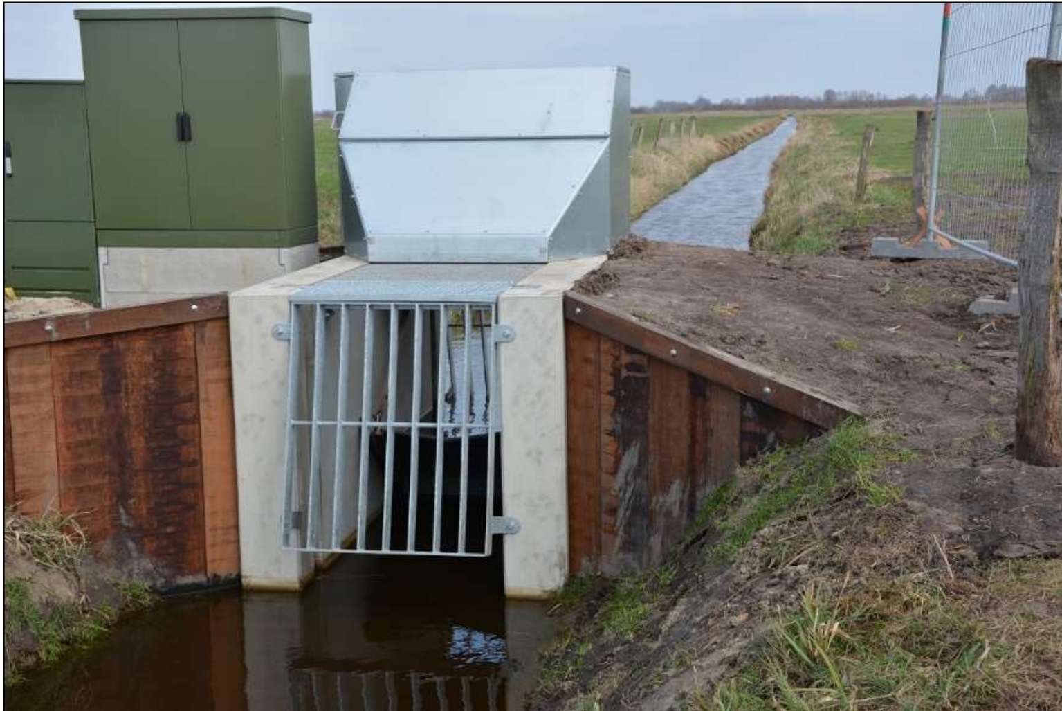
Stauwehr am Großsander Schloot, April 2021, Blick ins Plangebiet
