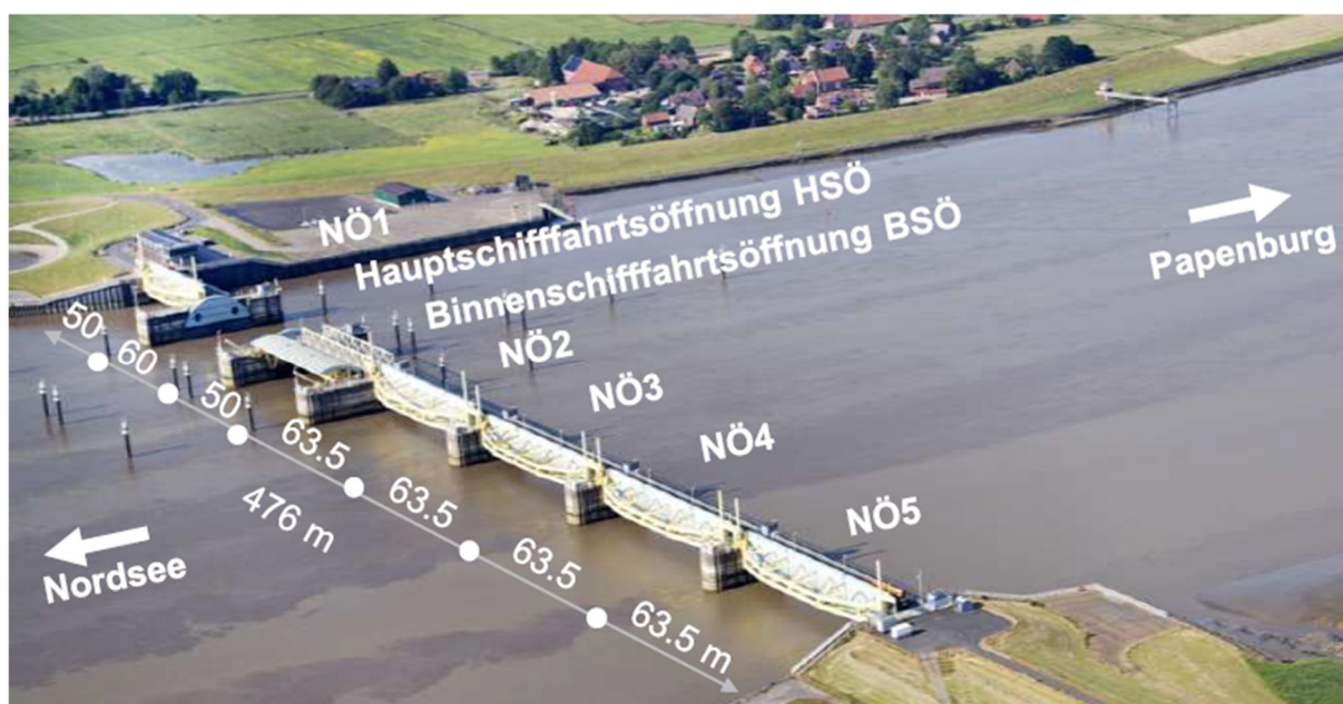
Abbildung 7: Totalansicht des Emssperrwerks (Quelle: BAW)
