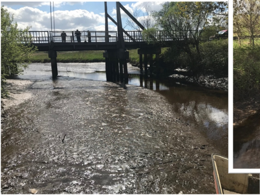
Unterlauf Augustfehnkanal / „Staaßenbrücke“ am 25.04.2020
