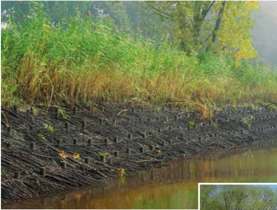
Naturnähere Befestigung: An der Wümmung bei Bremen besteht das Deckwerk aus Holzgeflecht, an der Ems dominieren Steine das Bild
