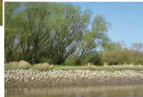
Naturnähere Befestigung: An der Wümmung bei Bremen besteht das Deckwerk aus Holzgeflecht, an der Ems dominieren Steine das Bild
