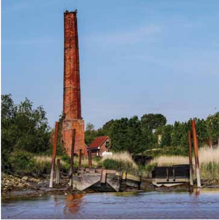
Ruine der ehemaligen Ziegelei „An der Ems“ in Jemgum: Anfangs war die Lage außendeichs am Fluss ideal, später wurde sie zum Nachteil
