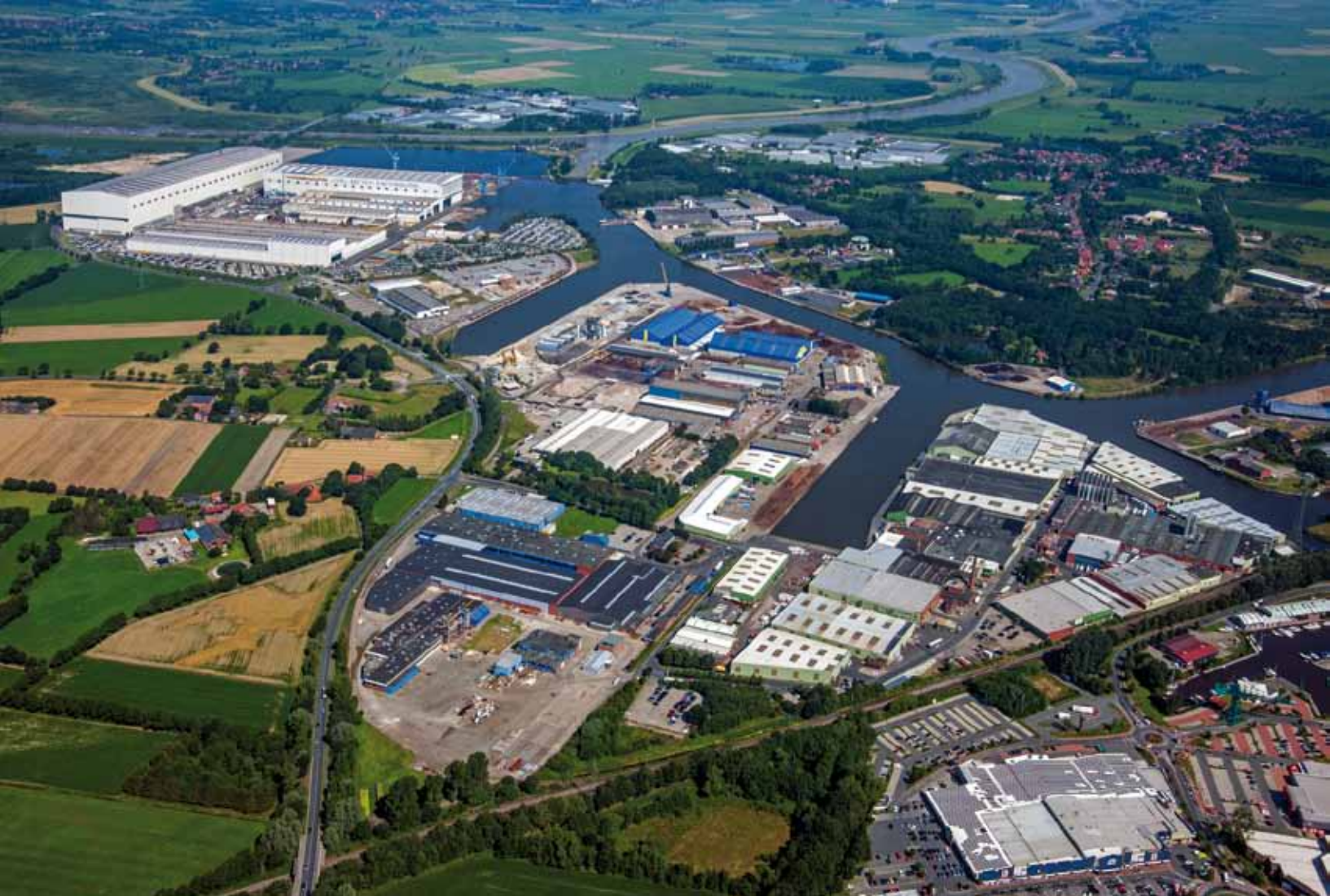
Klar zu erkennen: Die Seeschleuse im oberen Teil des Bildes bildet die Zufahrt zu den Betrieben und Umschlagsanlagen des Hafens. Sie wird ab 2020 erneuert.
