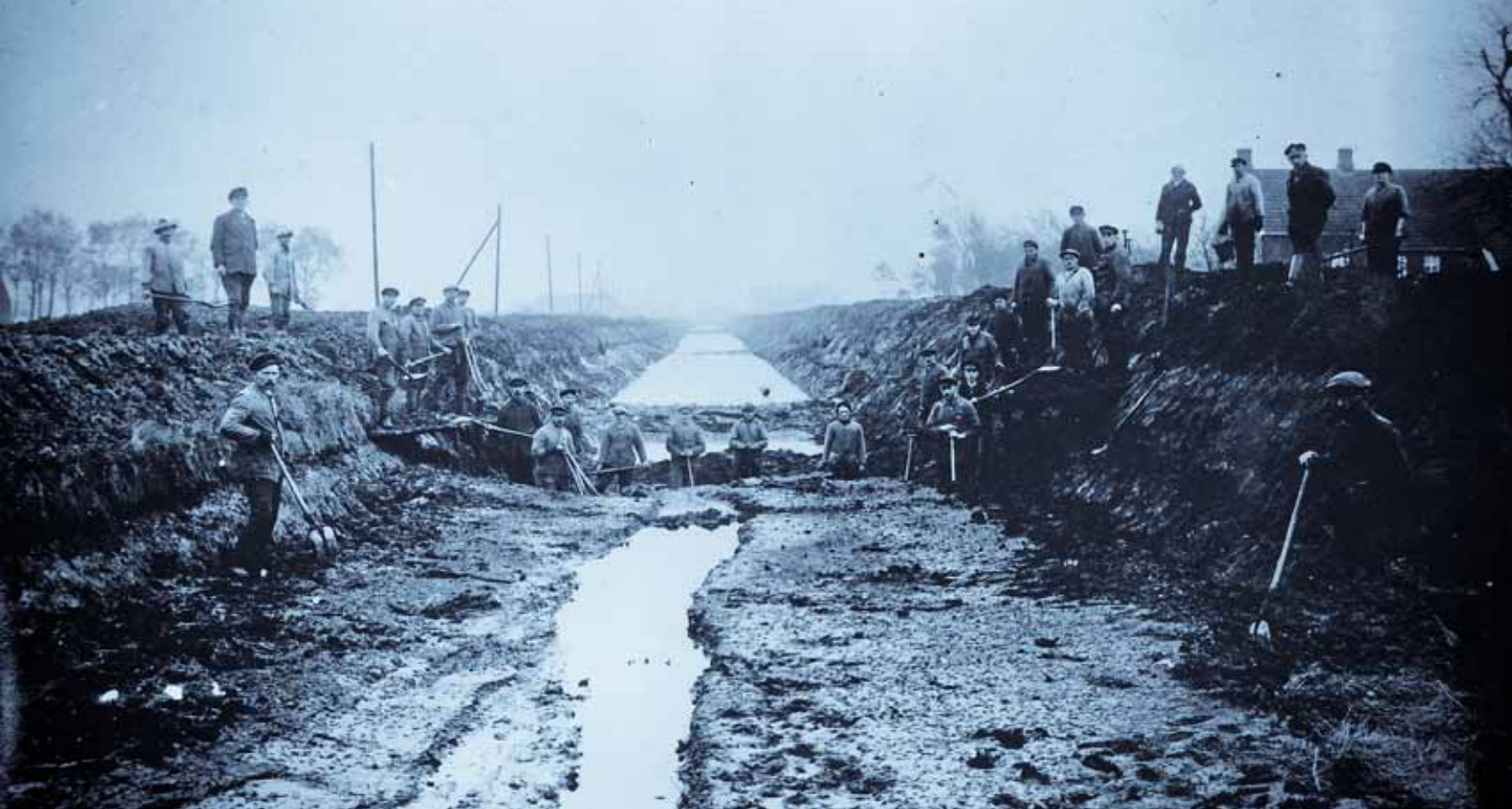
Harte Arbeit für bewohnbares Land: Kanalausbau in Handarbeit am Rajen.
